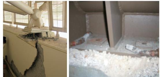
写真1、東日本大震災に損傷した接合部の例
