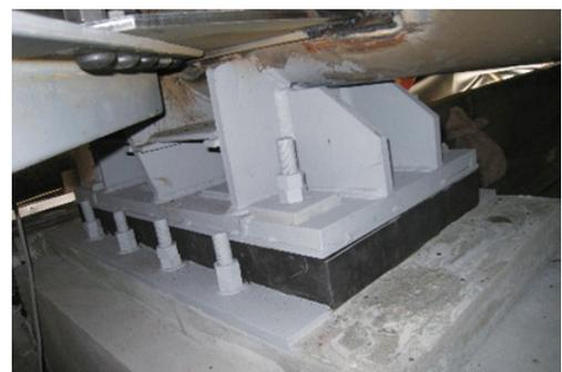
写真2、ゴムを用いた補強例
