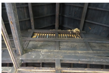
写真4 興福寺庫裏屋根裏
