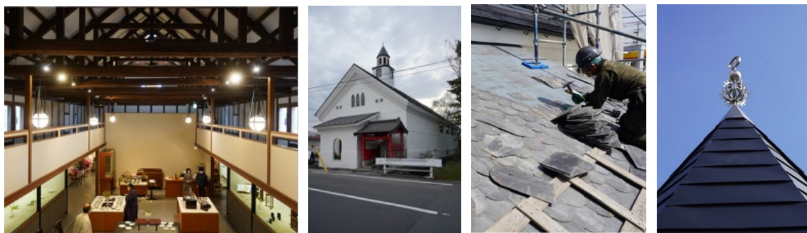
左より写真 1~4 新工藝蘭學舎内観, 再生後外観, スレート施工風景, 萩原氏協力のフィニアル
