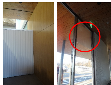
図2 アコーディオンドア(左)と北側出入口の風除け(右)
