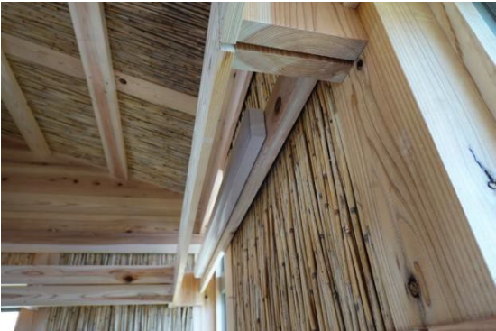
図 7 地元の茅(ヨシ)を用いた断熱材
