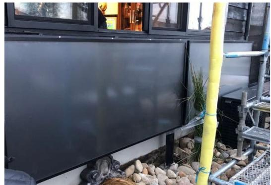
図7 太陽熱集熱パネル(居間の南側外壁)
