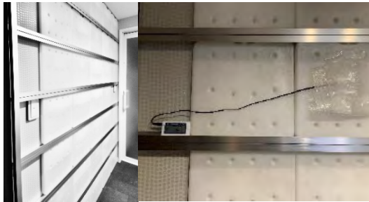
Fig.8 脱衣室に設置した潜熱蓄熱材(PCM)
