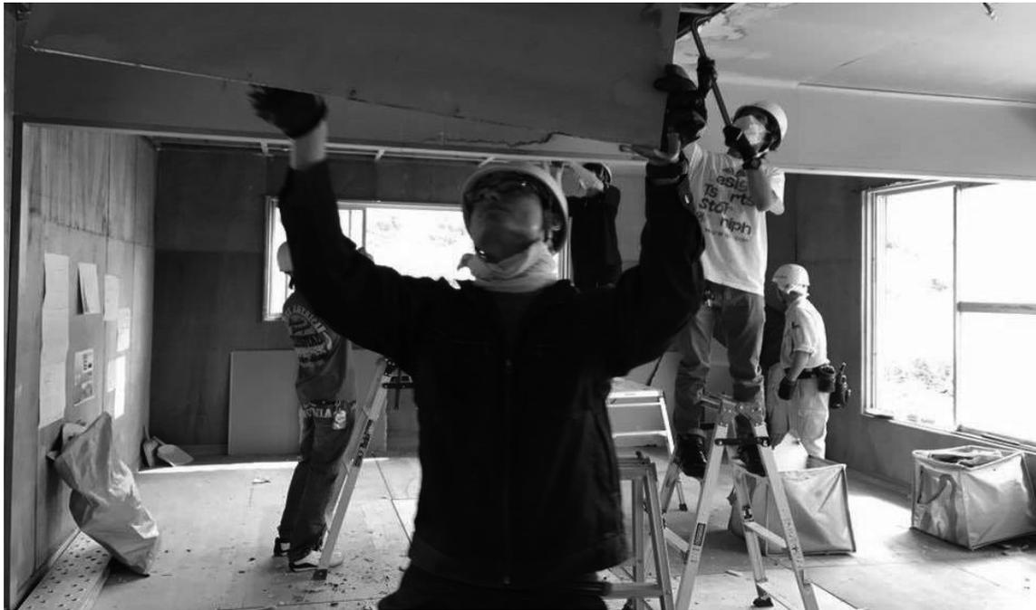
図3 小屋改修作業の一コマ(天井を外しています)
