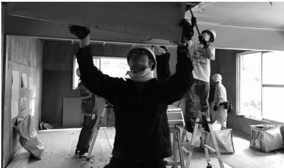
図3 小屋改修作業の一コマ(天井を外しています)
