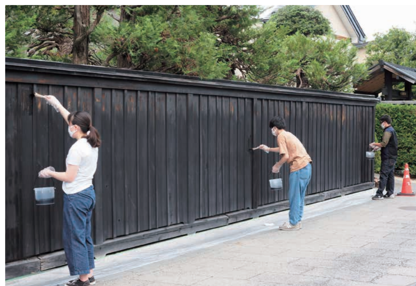
黒板塀の伝統的修理(柿渋塗装)
