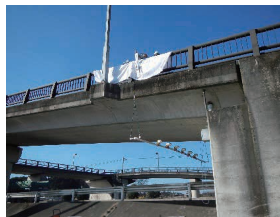
点検システム開発状況1(実地試験)
