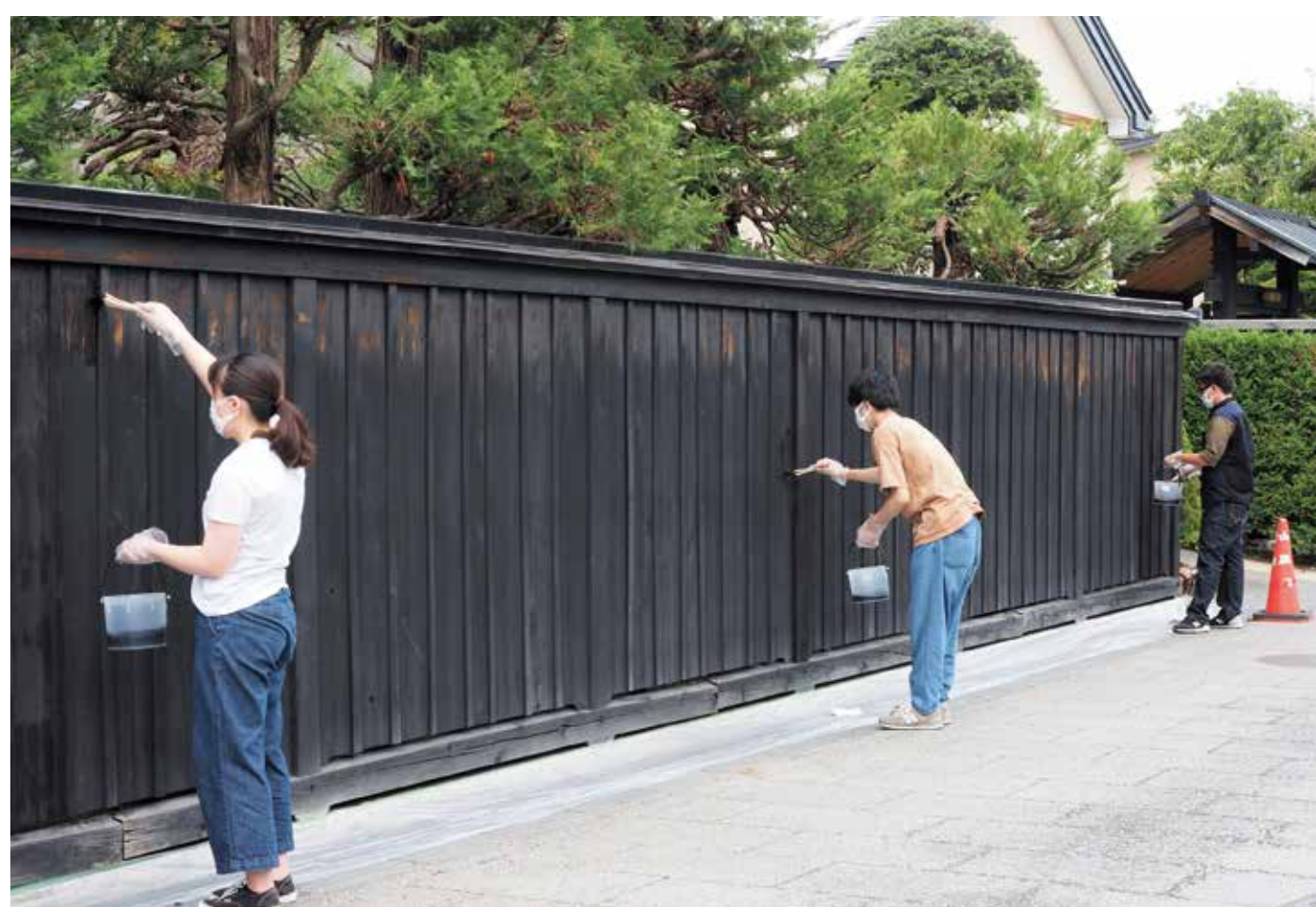
黒板塀の伝統的修理(柿渋塗装)
