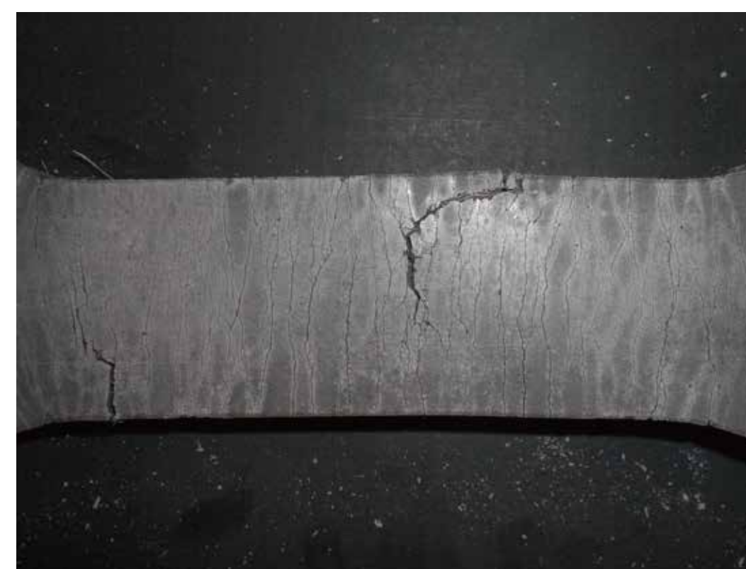
コンクリートに発生するひび割れ
