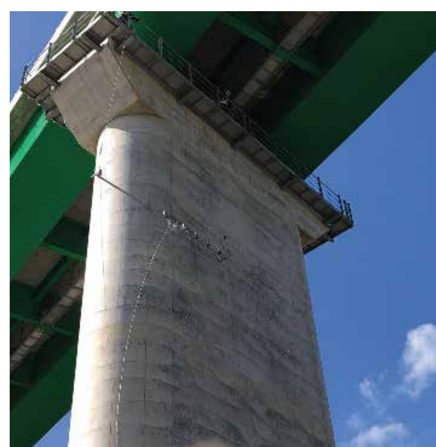
点検システム開発状況2(実地試験)
