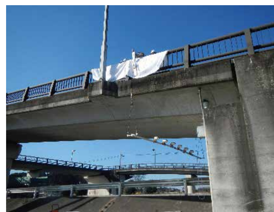
点検システム開発状況1(実地試験)
