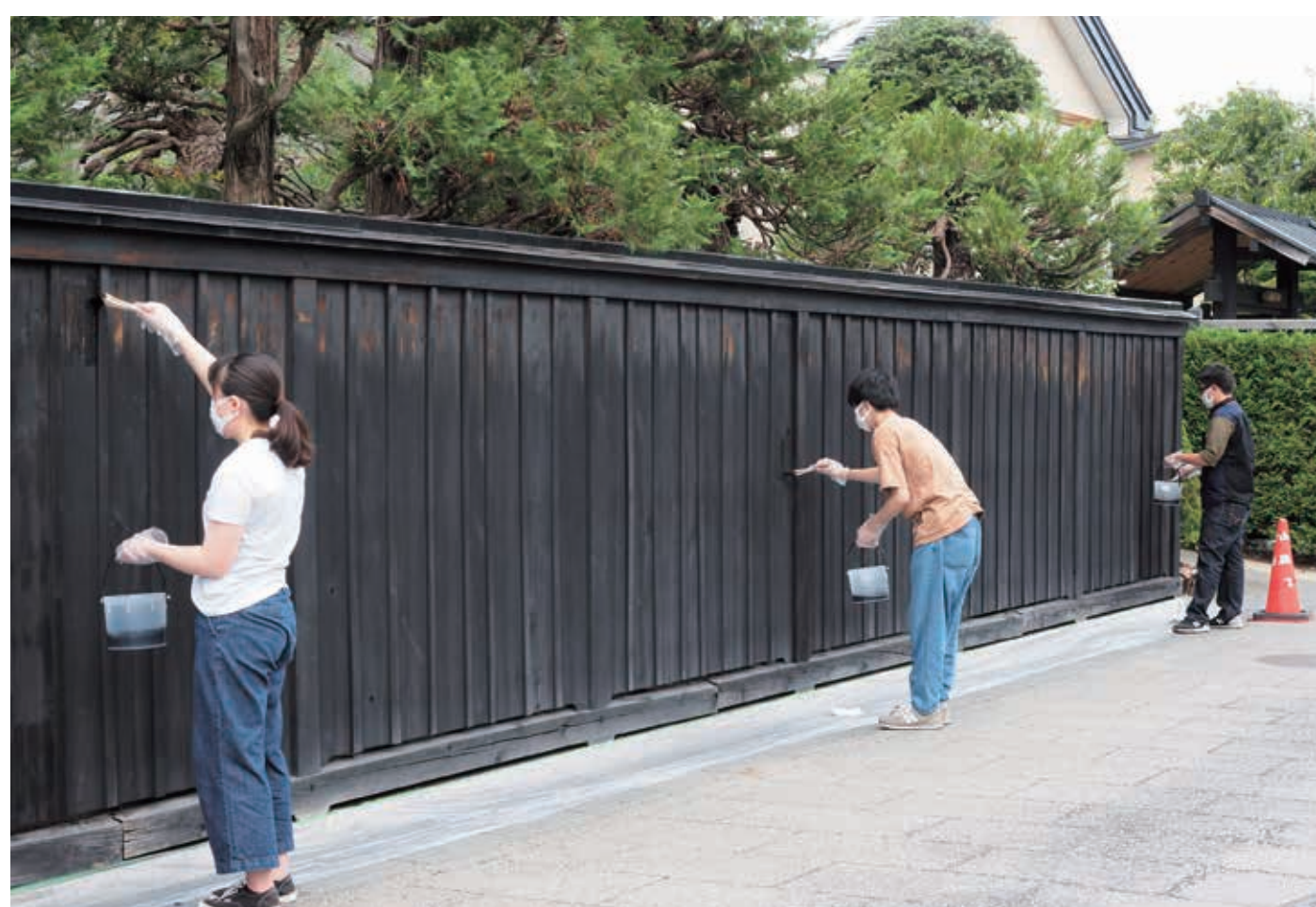
黒板塀の伝統的修理(柿渋塗装)
