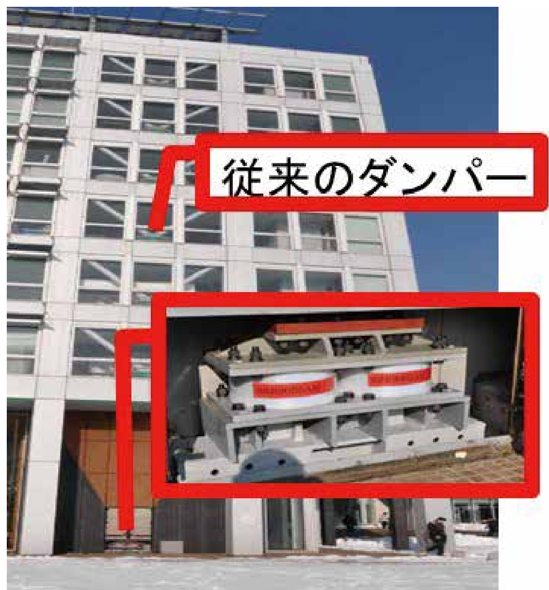
本学10号館、世界初のハイブリットレトロフィット制振構造物
