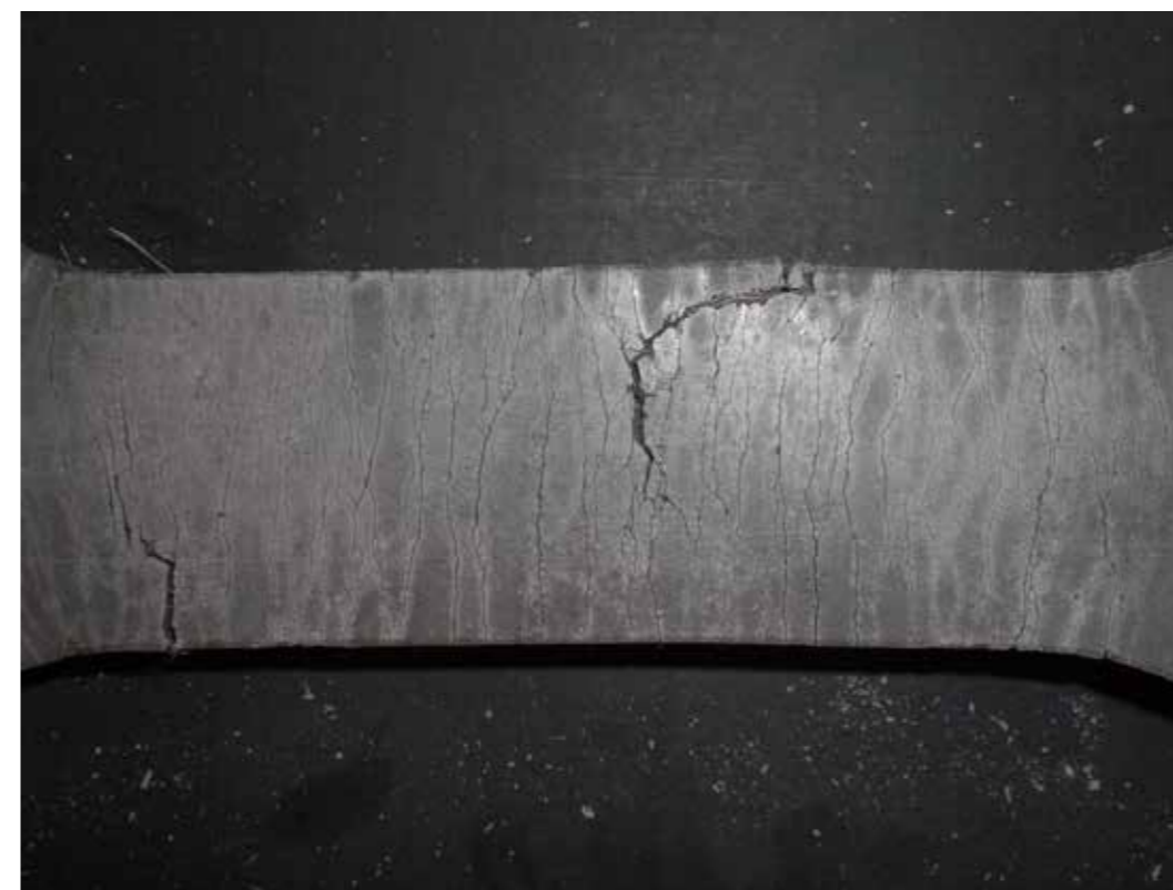
コンクリートに発生するひび割れ
