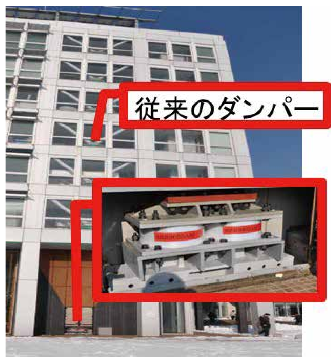
本学10号館、世界初のハイブリットレトロフィット制振構造物
