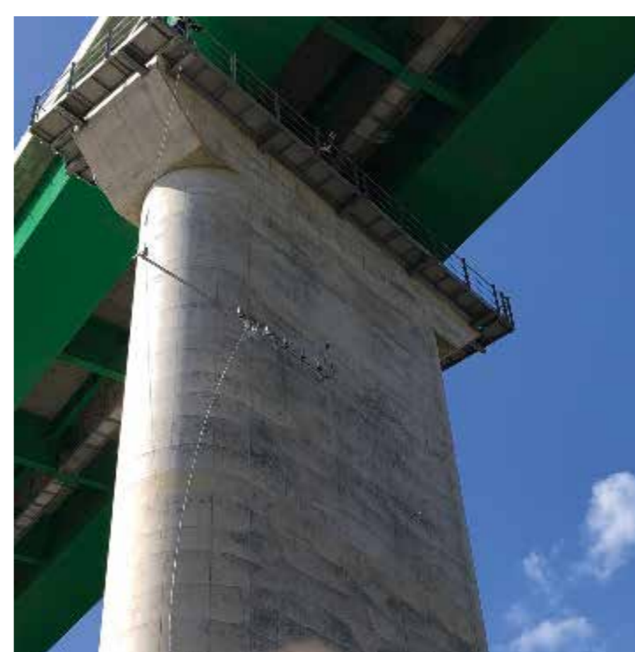
点検システム開発状況2(実地試験)
