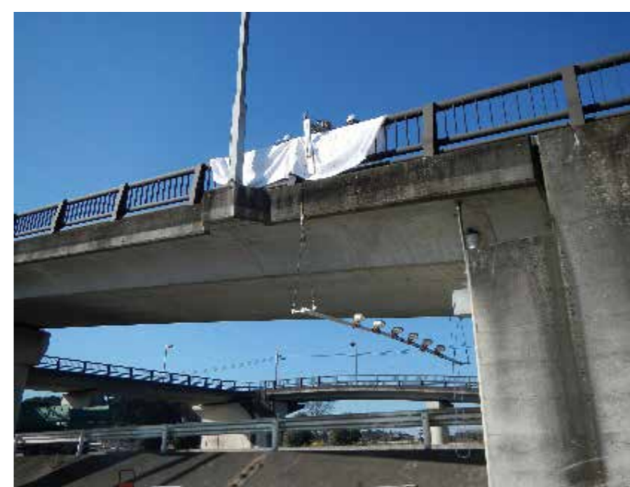
点検システム開発状況1(実地試験)
