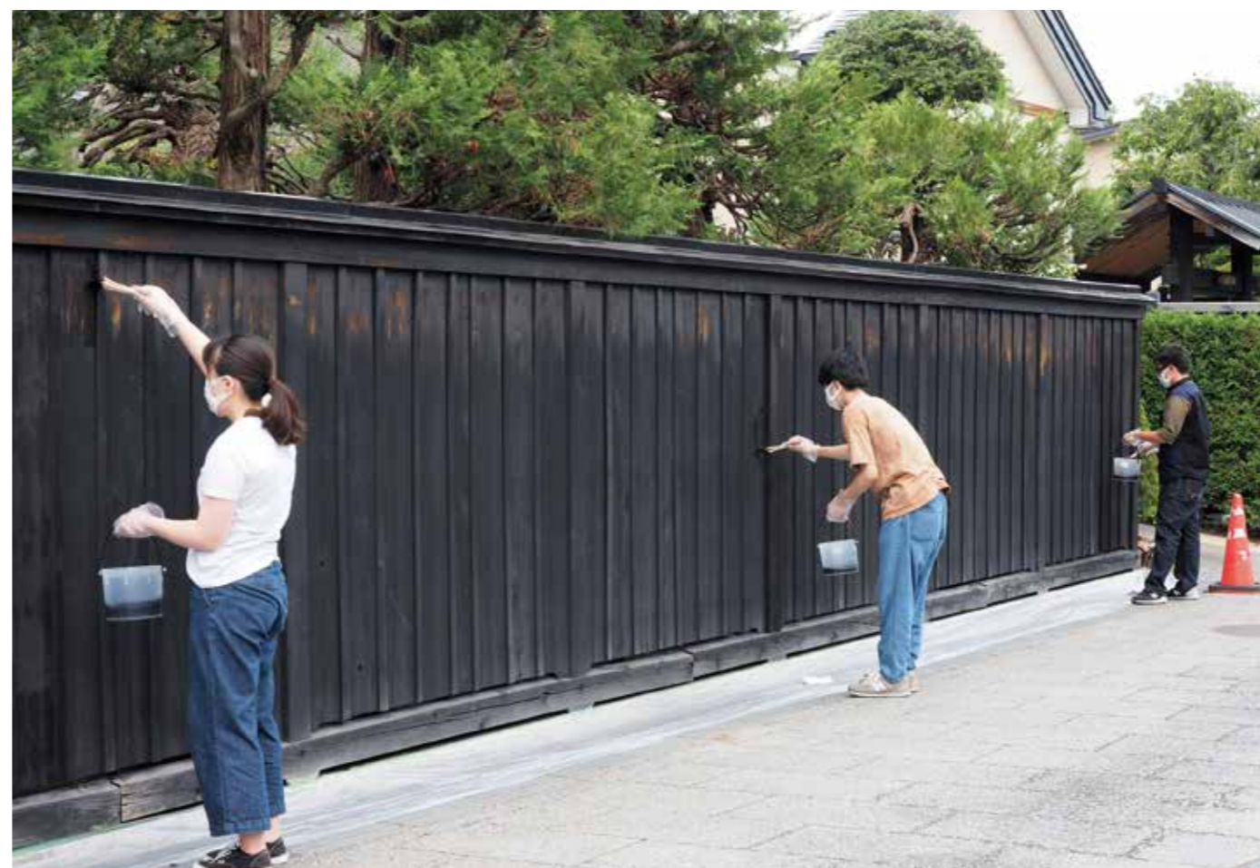
伝統的塗装による黒板塀の修復
