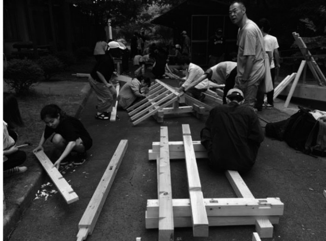
写真2 部材の仮組みと仕口継手の調整加工
