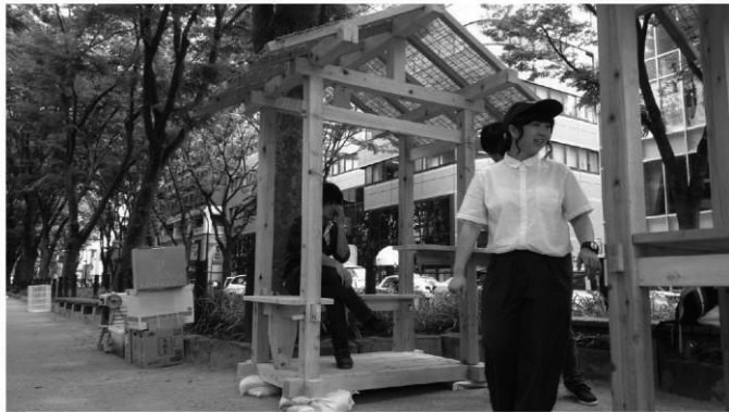
写真4 定禅寺通中央緑道での仮設組立て
